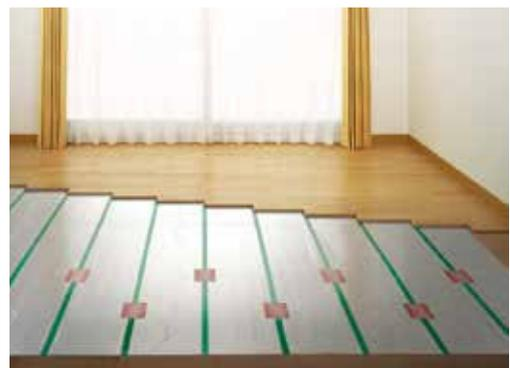
床板を張り、床暖房パネル・フローリングを施工 (画像提供: 東京ガス)
