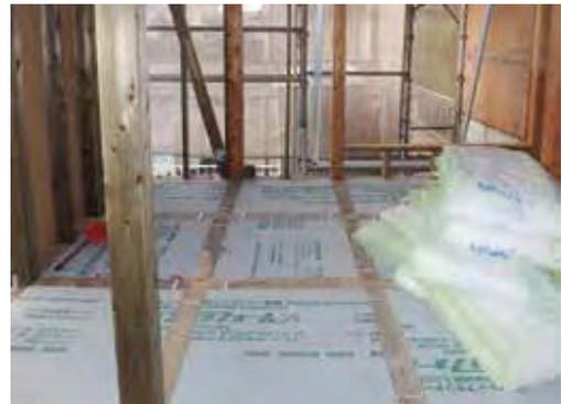
床板を撤去し、床下に断熱材を施工 (画像提供: エコワークス)
