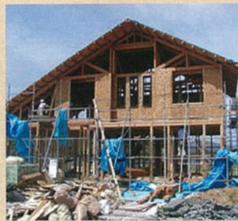
建物の再建改修中。壁内への浸水を心配していたが、断熱材のダメージが少なかった
