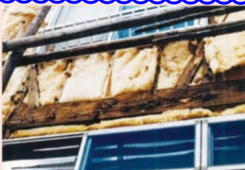
経年の水分の吸収と自らの重さでズレ落ちた繊維系断熱材の例
